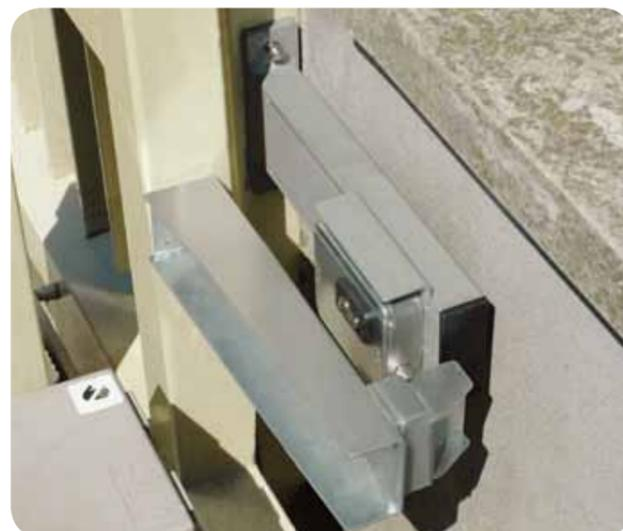
Aplicação no aro de segurança utilizando a "placa em T" de fixação, fornecida no Kit.
