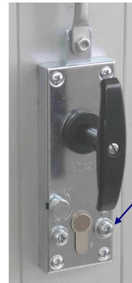
Tornillos que pasan por las perforaciones a norma DIN para aplicar el escudo de seguridad.
