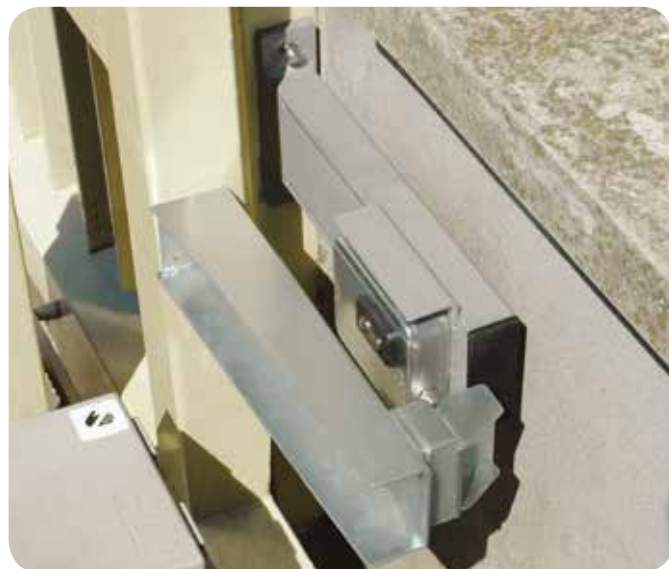
Montage auf dem "Pfosten mit Kippschutzführungen" mit der "T-Platte" aus dem Kit.
